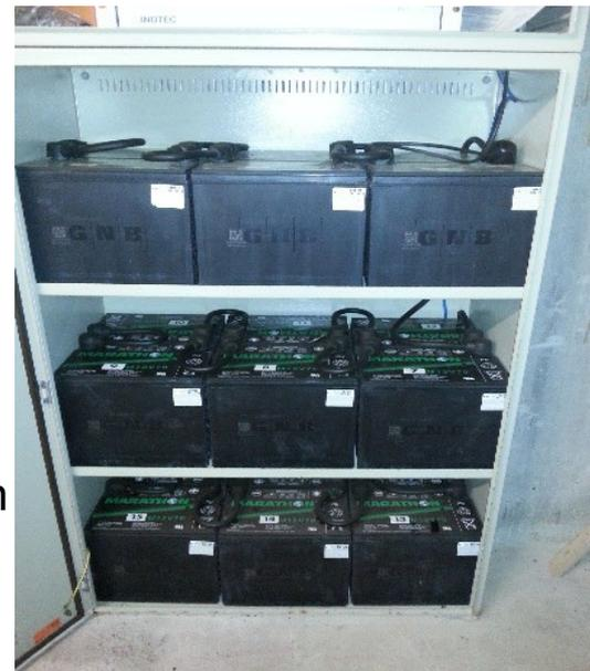
Batterien sind den hohen Temperaturen im Technikeller ausgesetzt.
