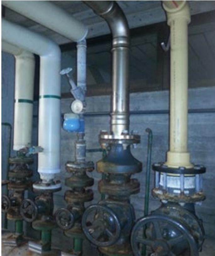
Kaltwasserabgänge aus unterschiedlichen Materialien, fehlende Isolierung
