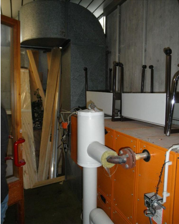
Nicht isolierte Außen- und Fortluft-Kanäle, RLT- Anlage Ebene 4
